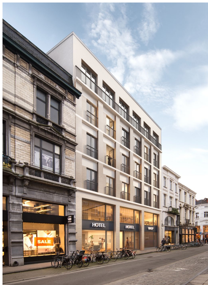
links: nieuwe gevel Veldstraat - rechts: nieuwe gevel Voldersstraat
