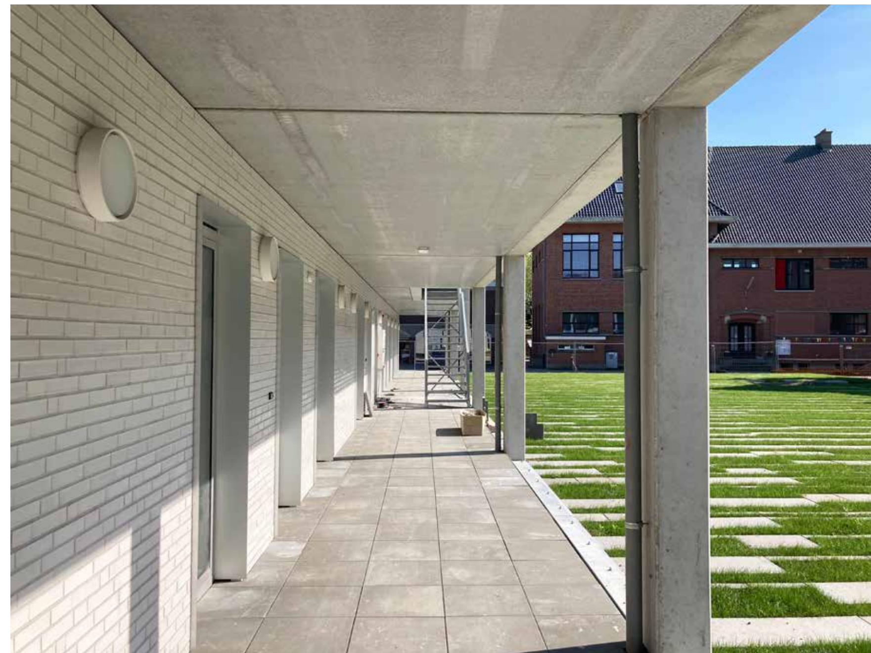
In een hedendaags gebouw, rond een centraal binnenplein, verzezen 39 sociale appartementen.
