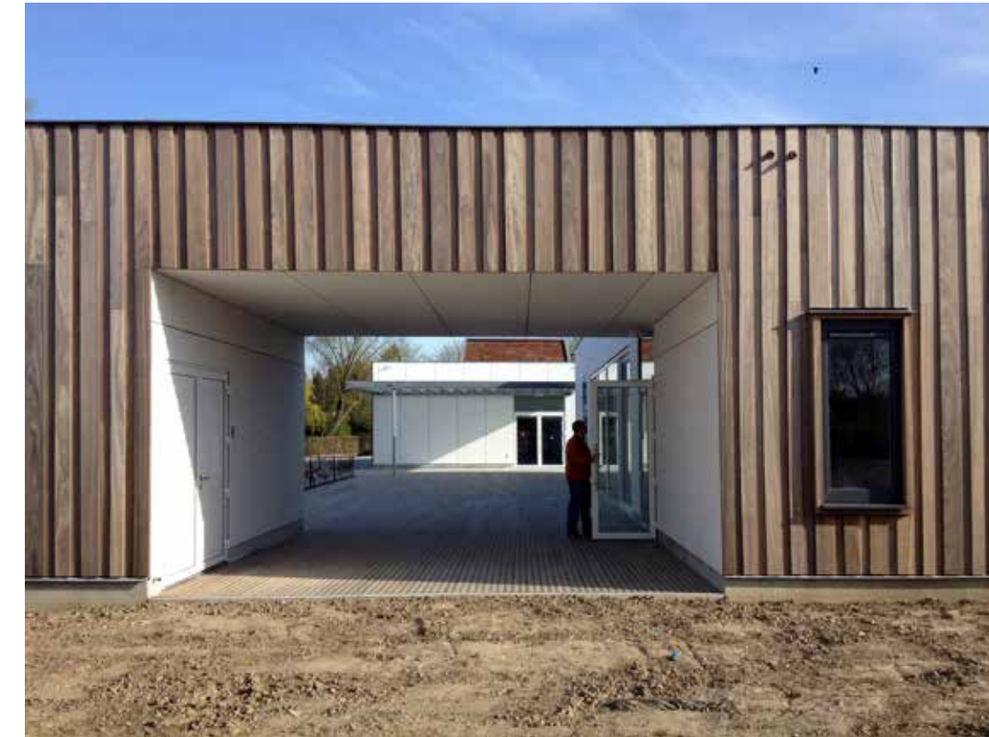
Groendak met dakopstanden met invallend daglicht langs het noorden en zonneboilerpanelen langs het zuiden.
