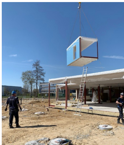
containerbouw - foto Abscis Architecten
