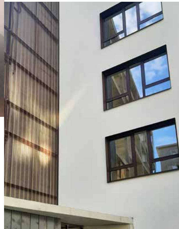
Het gelijkvloers en de eerste verdieping van Menslievendheid zijn gerealiseerd in ter plaatse gestort beton.
