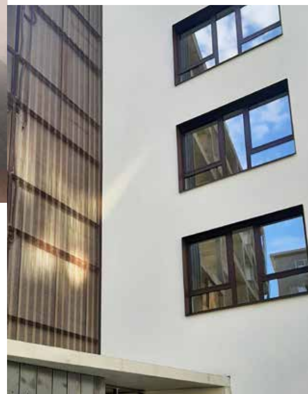
Het gelijkvloers en de eerste verdieping van Menslievendheid zijn gerealiseerd in ter plaatse gestort beton.
