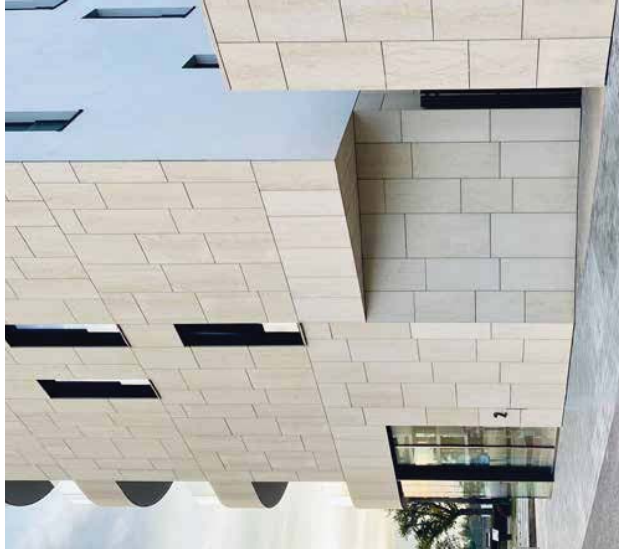
De betonstructuur is afgewerkt met grote natuursteenplaten in een lichte tint en brons geanodiseerd aluminium schrijnwerk.
