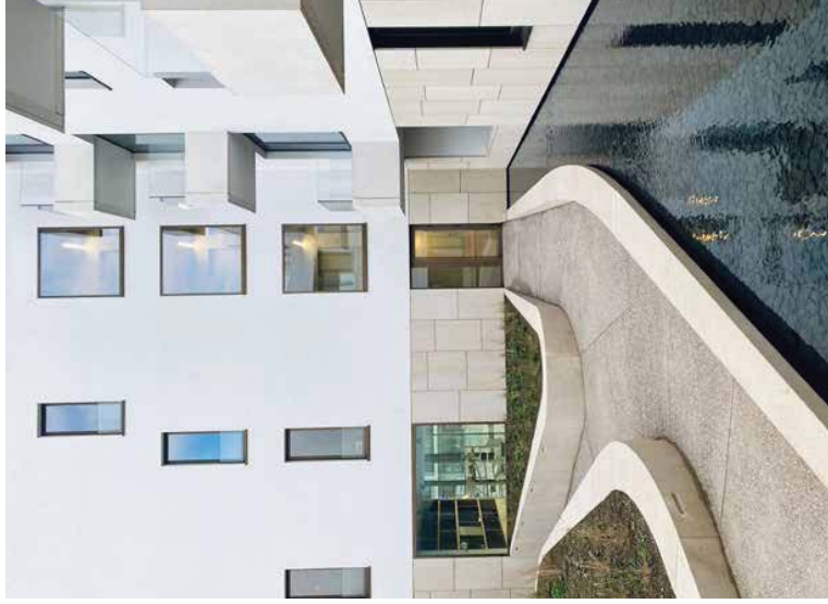
De betonstructuur is afgewerkt met grote natuursteenplaten in een lichte tint en brons geanodiseerd aluminium schrijnwerk.
